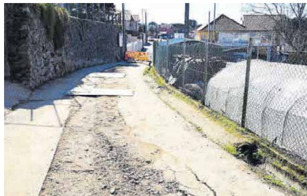
Trabajos en la bajada de A Torneira, que parte de San Martiño. | G. Núñez
