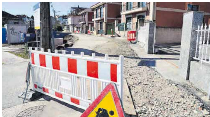
Estado, ayer, de las obras en el camino de A Lameira. | Gonzalo Núñez
